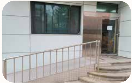
4월 자동출입문 설치
